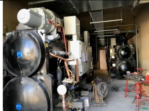
Figure 6 : Mise en place des pompes à chaleur
