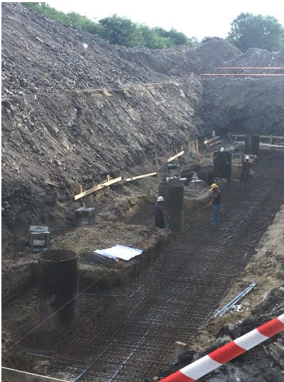
Figure 1 : Mise en place de la plateforme de forage et des 4 têtes de puits
