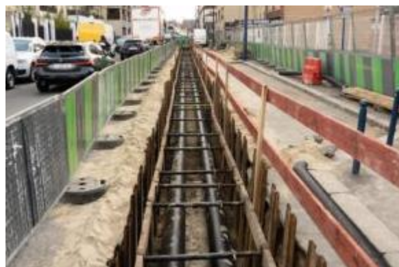
Figure 7 : Déploiement des canalisations du réseau
